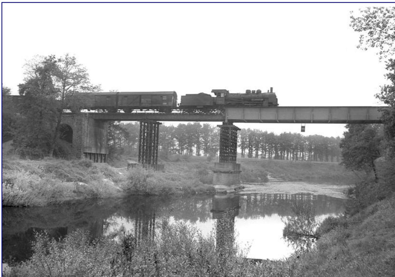
Schnell fahrende Lokomotiven wie die Baureihe 38<sup>10-40</sup> waren bevorzugte Maschinen für den Transport von Leig-Einheiten. Ein solcher Zug überquert am 16. Mai 1952 in Rheine die Ems auf der behelfsmäßig wieder aufgebauten Brücke in Richtung Quakenbrück. Typisch für die Bundesbahn wurde das Fehlen der auffälligen Schriften auf den Wagen. Foto: Quebe, Sammlung Eisenbahnstiftung
