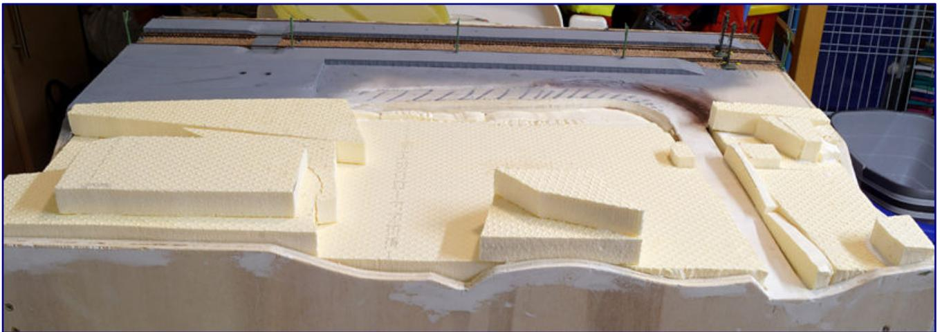
Die zugeschnittenen XPS-Plattenteile werden mit Uhu-Holzleim, flächig mit dem Pinsel aufgetragen, aufgeleimt und geschichtet, um die Landschaft im Anschluss „aus dem Vollen“ schneiden zu können.
